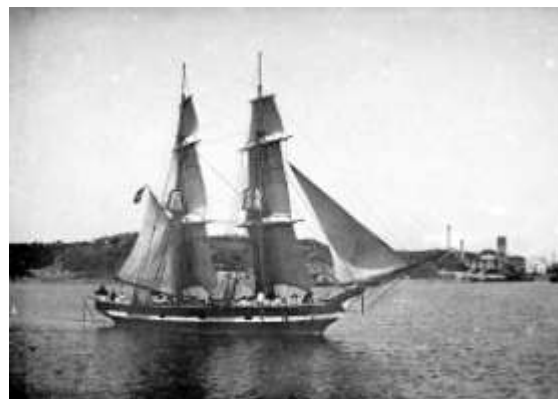
Skeppsgossebriggen Skirmer, byggd 1867, utrange- rad 1899. Längd 18,9m, bredd 6,3m, 80ton, 321m 2 . Besättning 54 man varav 48 skeppsgossar.
