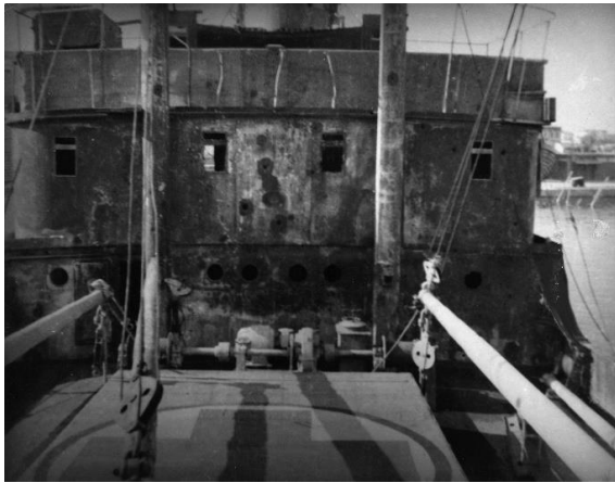
Obs skotthålen i brygghuset. Ett tomt skal återstår.
