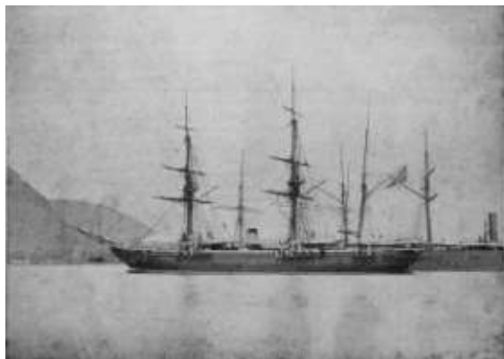
Skrufångkorvetten Gefle, byggd 1848, flottans första fartyg med propeller.
